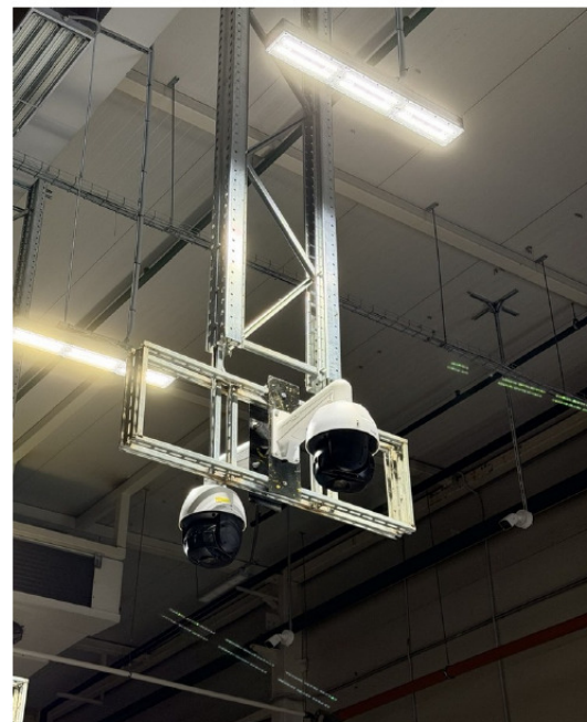
Узел крепления двух камер
