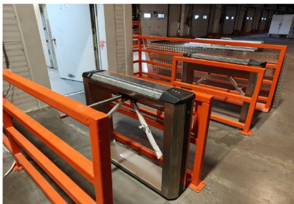
Фото смонтированной входной группы
